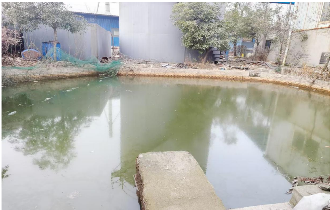
初期雨水收集池（兼做事故池）
