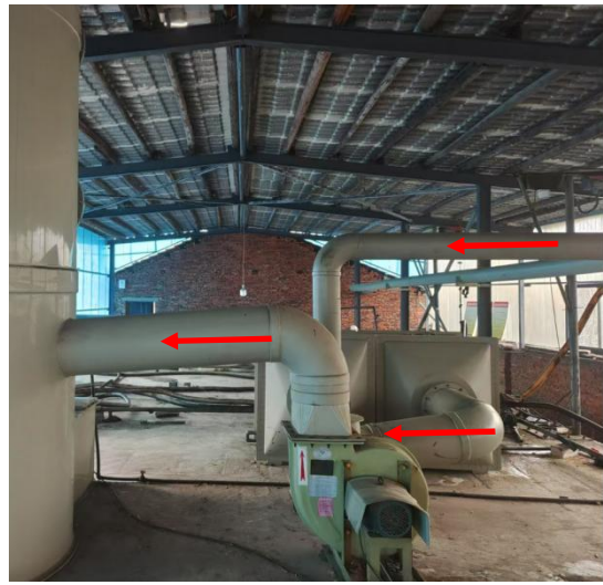
蒸煮废气收集管道
