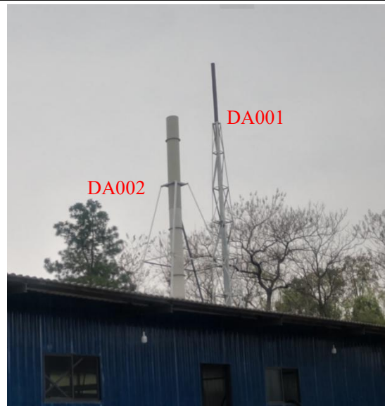
DA001和DA002排气筒
