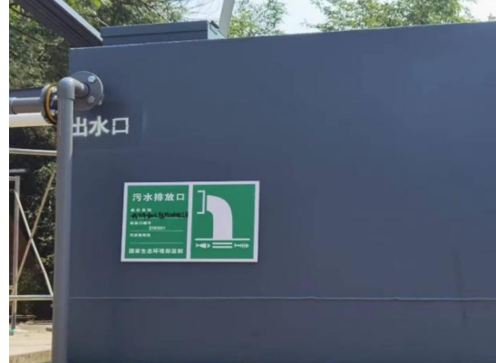
污水排放口标识牌
